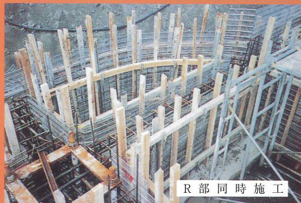
ラス型枠 仕上り状況
