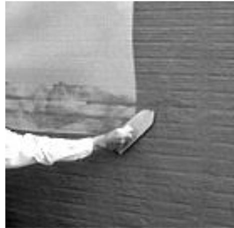
モルタル施工時のネット伏せ込み
