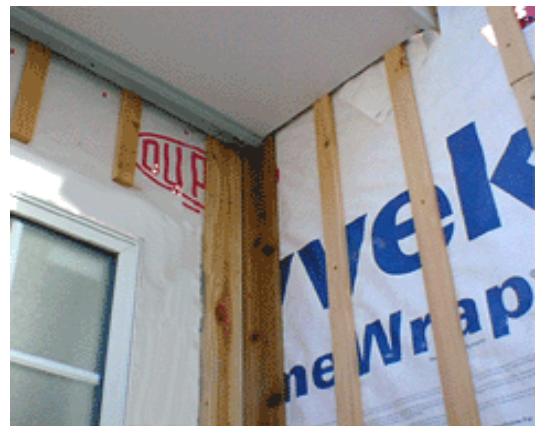
●入隅コーナー部分の施工写真
