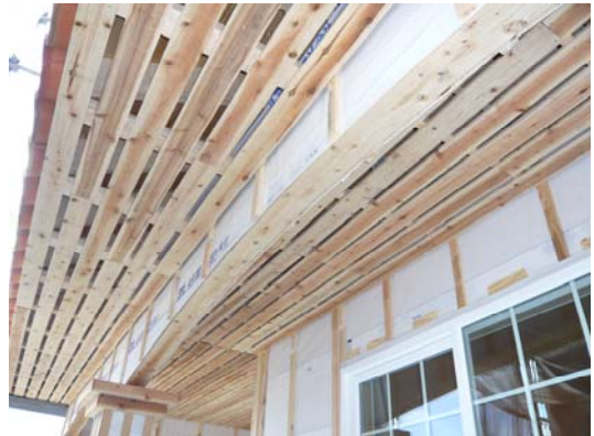
●軒裏・窓廻り部分・たれ壁の施工写真
