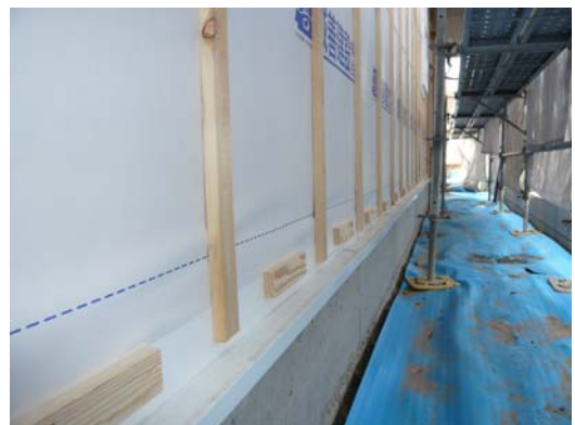
●胴縁一般部分の施工写真
