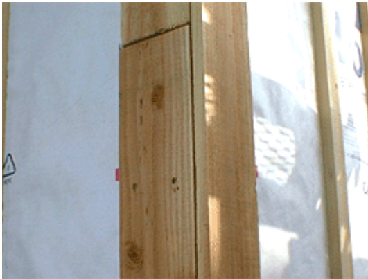
●コーナー部分の施工写真
