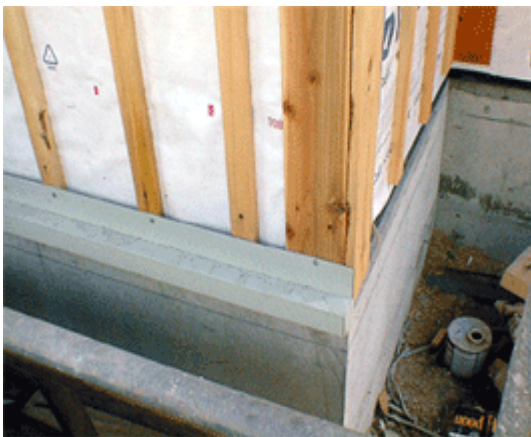
●出墨コーナー部分の施工写真
