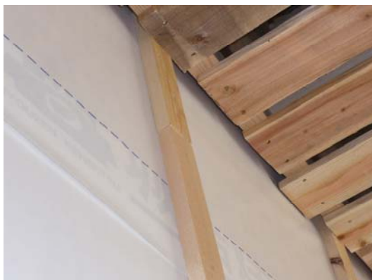
●軒天部分の施工写真
